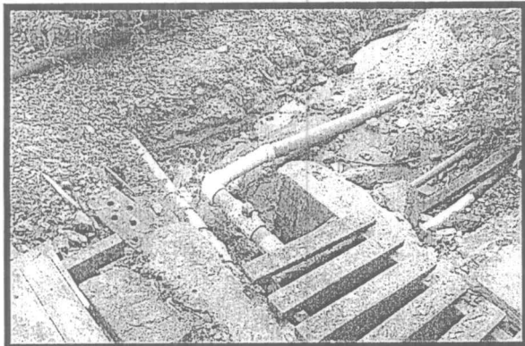
Fotos 3 y 4. Fuga en la tubería de transporte de aguas sanguinolentas y trampas de grasas (Área 1).
